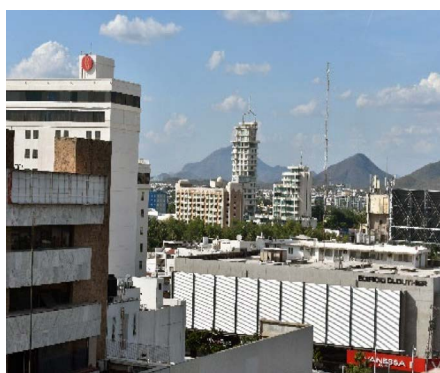
d) Edificio moderno misma esquina
