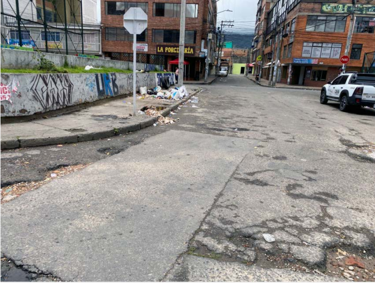
Figuras 2 y 3 Infraestructura peatonal construida localidad Rafael Uribe. UPZ. San José
