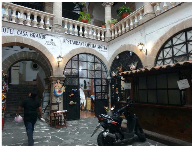
Imagen 41. Edificio del hotel Casa Grande, en el patio interior sobrepusieron locales comerciales
