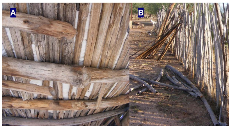
Figura 5. Utilización de tallos secos de Stenocereus thurberi en la construcción de tejabanos (A) y cercos (B)
