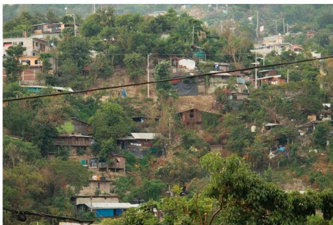
Figura 4.8. Viviendas en peligro de sufrir derrumbes o deslaves en Zihuatanejo.
