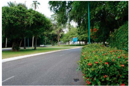
Figura 5.37. Calle y cableado subterráneo en el CIP Ixtapa-Zihuatanejo.
