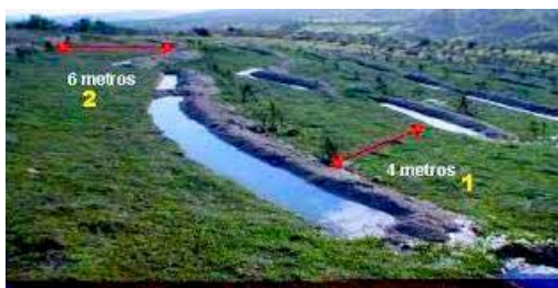
Figura 4. Dimensiones de las zanjas y el resultado de su implementación
