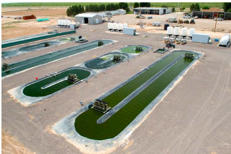
Figura 2. Vista aérea de un sistema de cultivo de microalgas en aguas residuales. Las microalgas cumplen una doble función: biorremediación y producción de biomasa.
