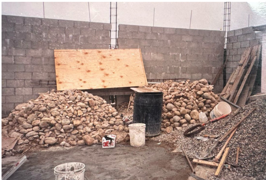
2.2 Esta es una imagen de nuestra casa en construcción en 1993. Mi hermano y yo juntábamos las piedras.
