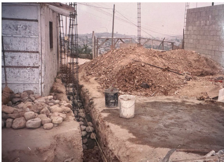
2.1 Para iniciar los cimientos de la nueva casa todo servía, todo se utilizaba. 1993.
