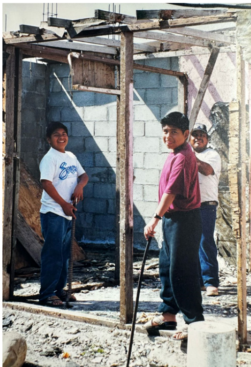
2.6 Con los huaraches bien firmes, trabajaba junto al albañil Toño mientras ayudaba a mis papás en casa. Aquí se aprecia la demolición de nuestra antigua casa de madera. 1999.
