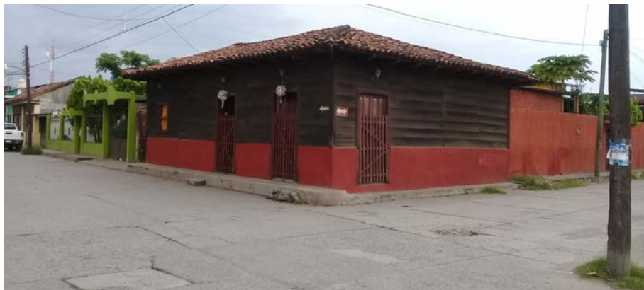
Casa de Agustín Wong, Morelos sur y Escobedo poniente, Mazatán, La casa está hecha de tejas, sostenida por madera de cedro, vigas de chiche y guanacaxtle. La casa donde se ve la camioneta también era de tejas y madera. Foto: Catarino Escobar Macías, julio de 2020.
