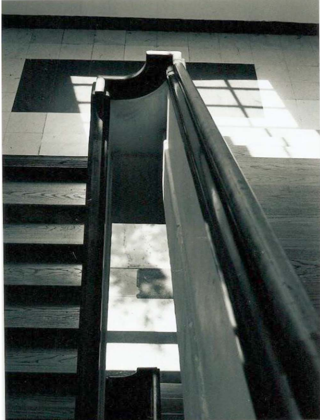
Foto 2. Escalera de la Casa de la Cultura de Tijuana
