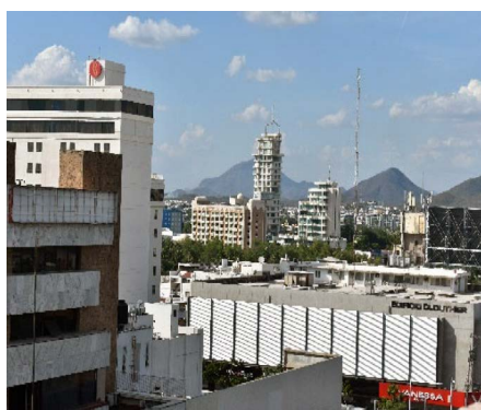
d) Edificio moderno misma esquina
