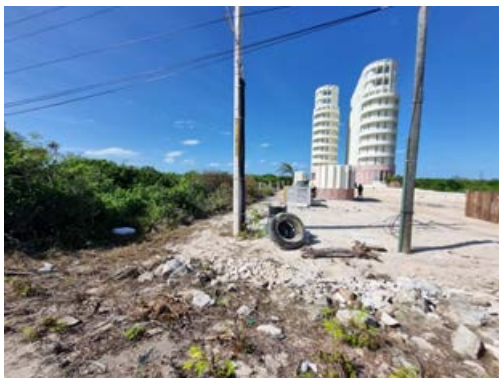
Fotografía 15. Acelerada construcción entre manglar
