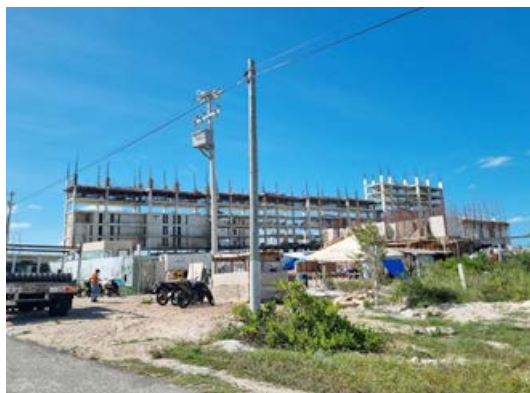
Fotografía 16. Mas construcción en Telchac Puerto agua
