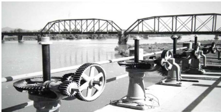
Fotografía 1. Compuertas del distrito de riego 010 Culiacán-Humaya. (1964).
